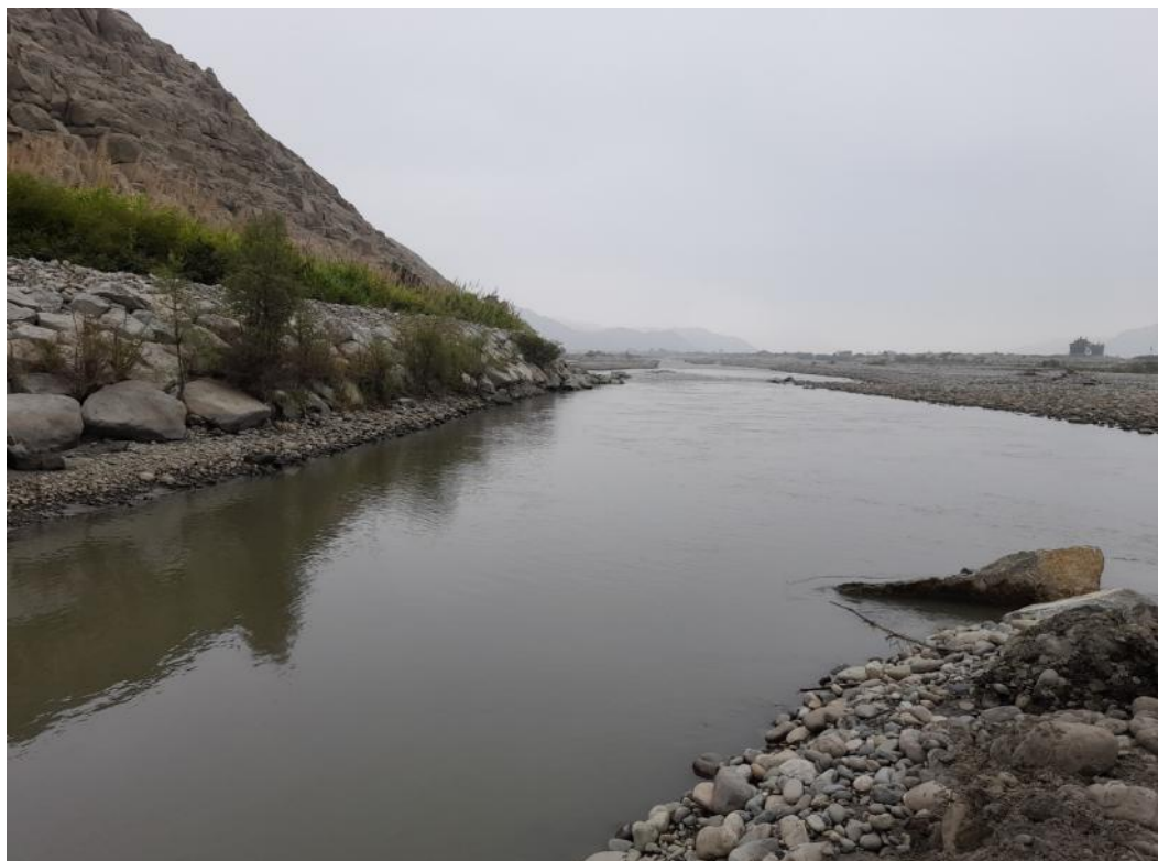
FIGURA N°02: ENTRADA DE LA BOCATOMA CUANDO AUMENTA EL RIO SANTA, SE SOCABA QUEDANDO COLGADA.
